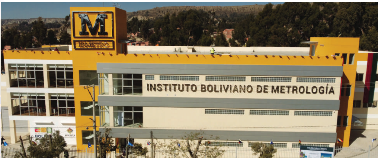
Laboratorios y oficinas del Instituto Boliviano de Metrología
