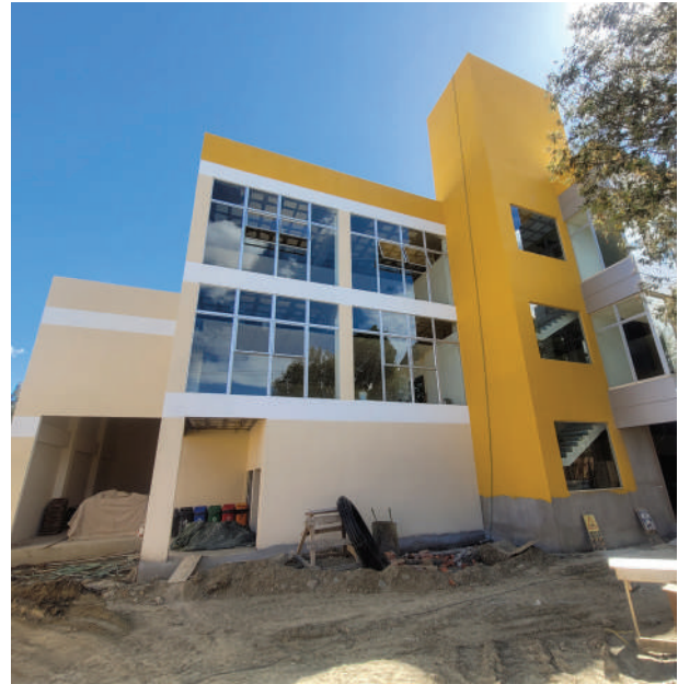
Vista del Frontis del edificio durante su construcción
