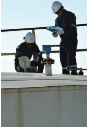
Prueba hidráulica a tanque estacionario
