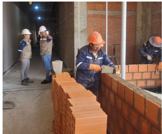
Proceso de construcción de los nuevos laboratorios
