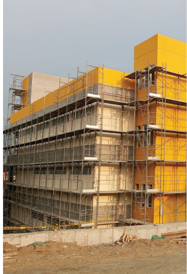
Imagen del frontis en el proceso de edificación
