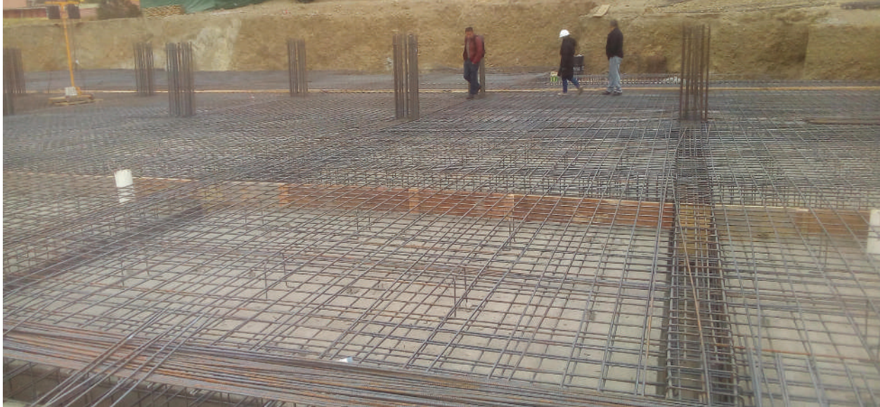
Construcción de la losa radier de fundación
