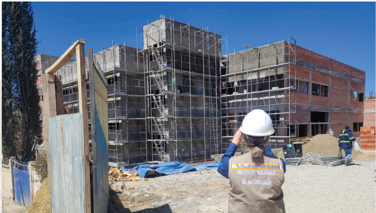
Inspección a las obras de construcción durante el año 2023
