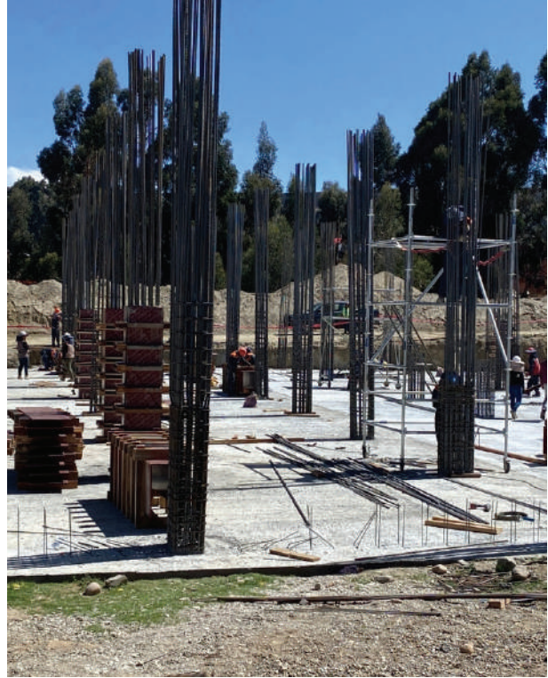
Construcción del primer piso del bloque principal
