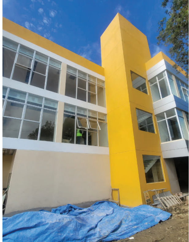
Vista de la fachada principal a pocos meses de la inauguración de la infraestructura
